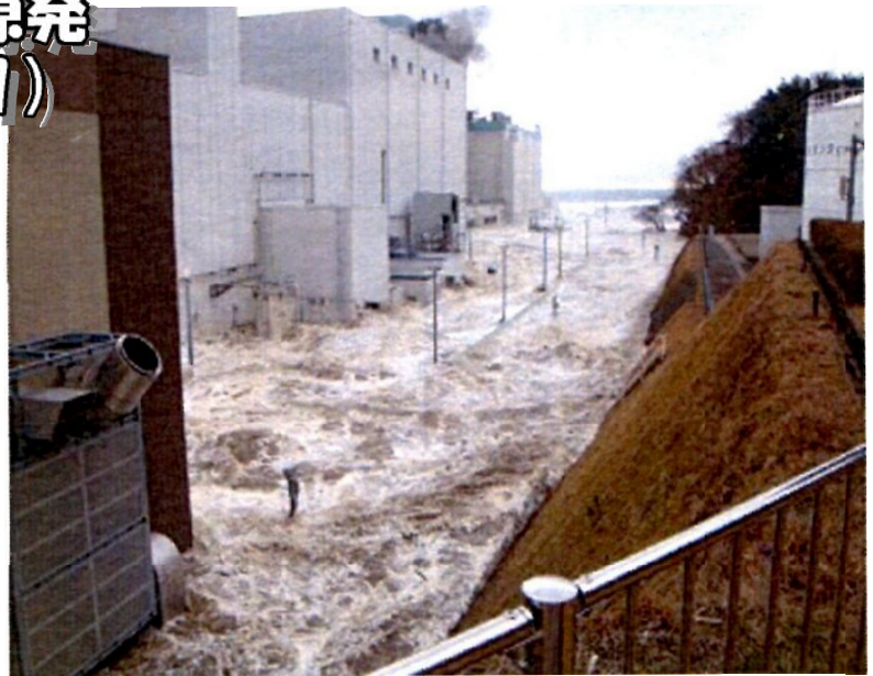
津波の到達：15：30頃。福島第二原発免震重要棟高台から、1号機方向を撮影＝東電提供資料
