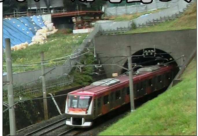
マンション建設現場(左上)と、工事の影響が心配されるトンネル(右下) = 10月29日撮影
